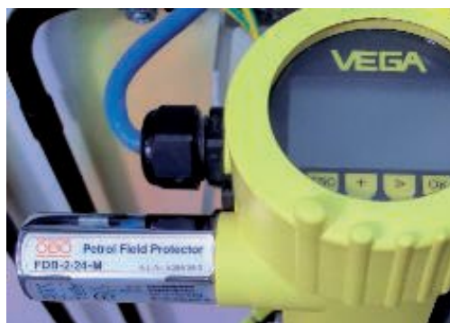
Obr. 4 Senzor vybavený modulom Petrol Field Protector FDB
