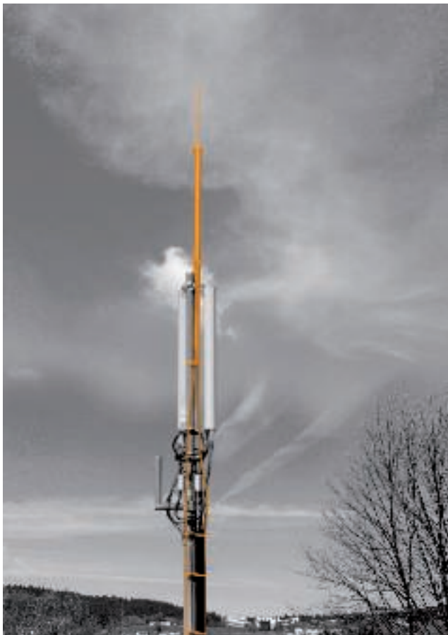
Stožár mobilního operátora se svodem isCon®
