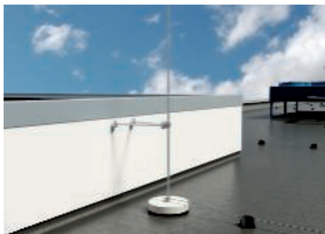
Oddělená ochrana před bleskem s izolačními příčnickami
