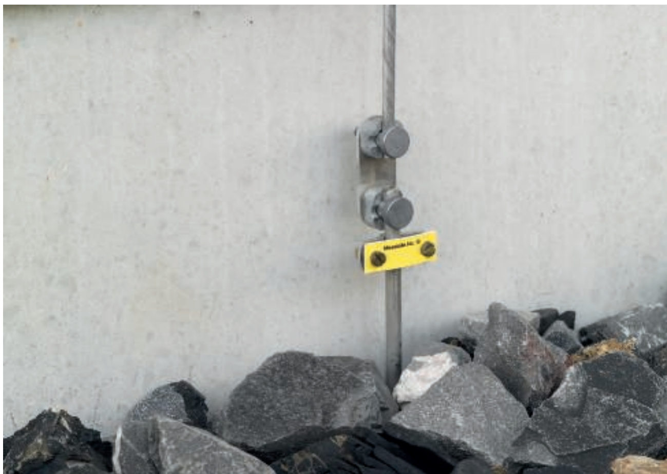
Oddělovací bod na kovové fasádě
