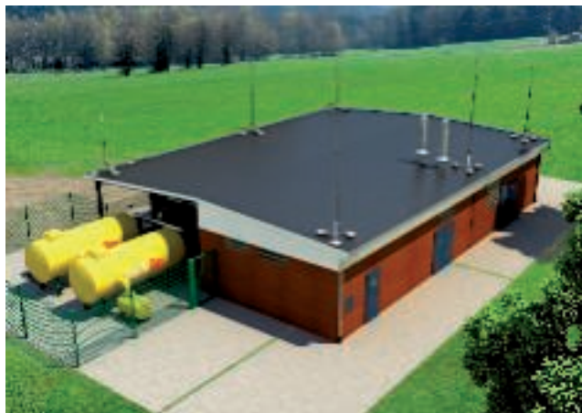
Svod isCon® na jímácím stožáru v prostředí s nebezpečím výbuchu
